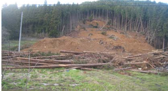
図 22 福島県白河市の岡の内地点の崩壊斜面 (筆者ら撮影)
