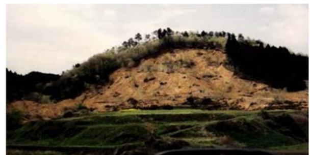
図 25 栃木県那珂川町押野の崩壊斜面 (目撃者から提供いただいた写真を使用)
