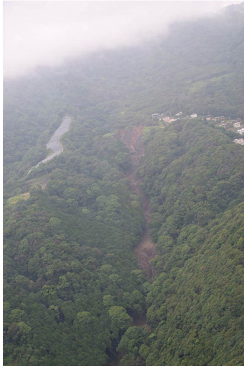
下流側から見た谷の浸食の様子、途中の幅広い部分が恐らく砂防ダム跡と思われる。 (読売新聞社へりより筆者撮影)
