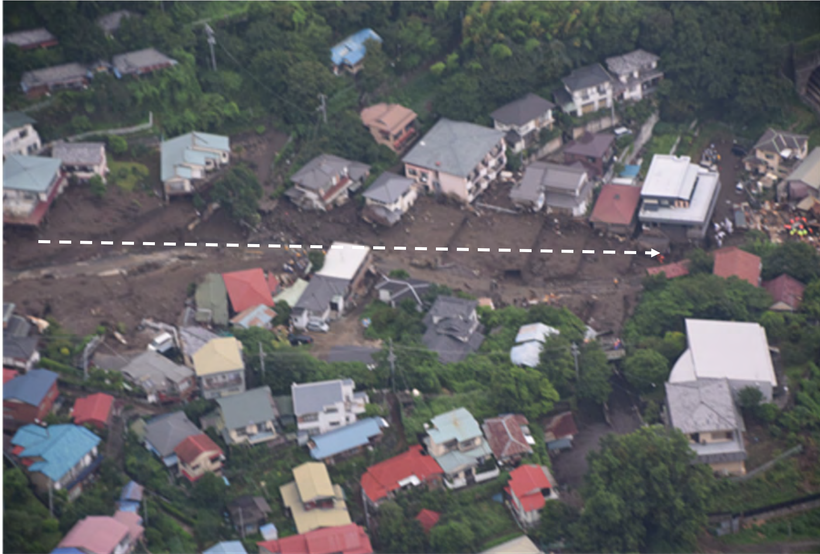
流された家屋の敷地間の段差は明瞭に残され、泥の堆積は道路から大きく溢れず。 (読売新聞社へりより筆者撮影)
