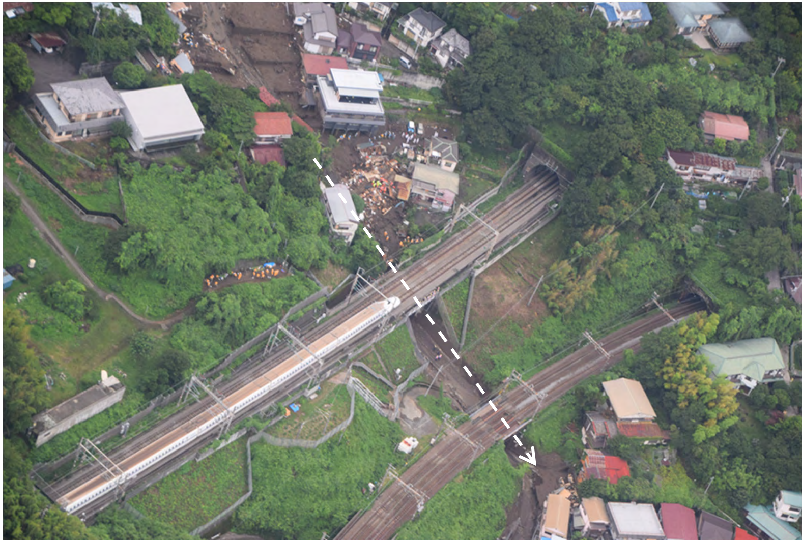
新幹線の橋梁下のクリアランスは十分あったようで、塞き上げの形跡は空から確認できず。 (読売新聞社へりより筆者撮影)
