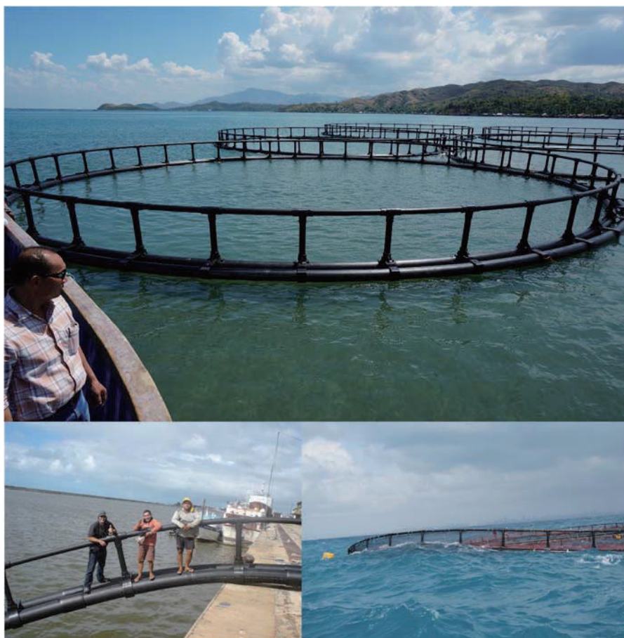
(直径 80m 管径 400mm 程度：大きな変形にも追随し破断しない)
