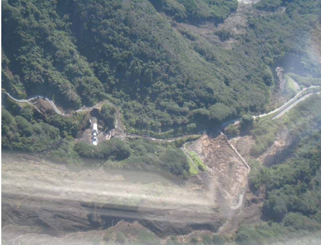
写真-7 砂防ダムは天端まで泥が溜まっているように見える。
