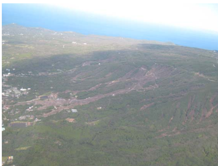
写真-2 南部より見た大島西斜面の崩壊。標高 400m から 60m まで 水平距離 1.6km、落差 340m。
