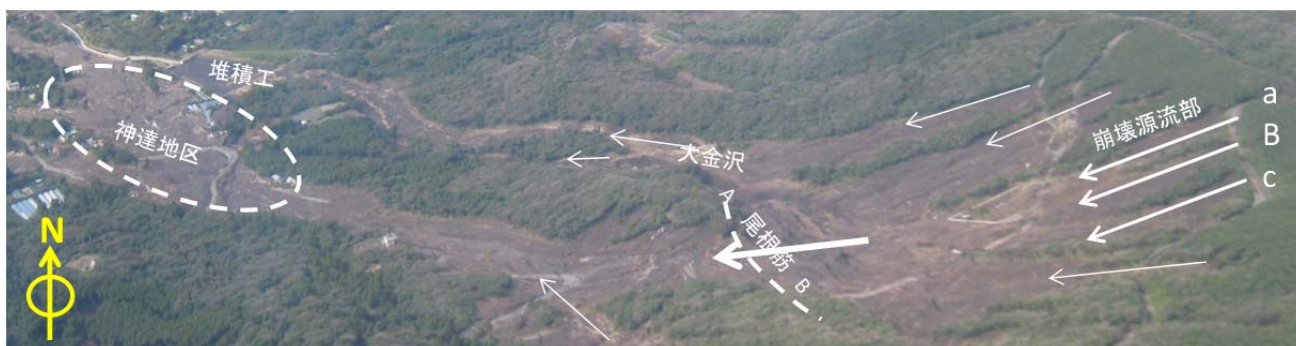
図-1 へりから見た崩壊斜面と泥流流下経路
