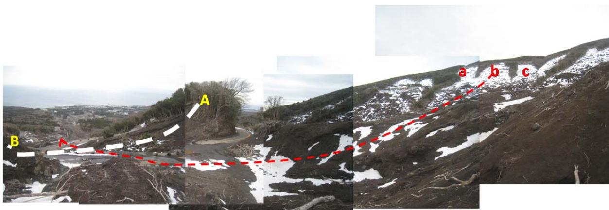
図-2 崩壊斜面 a,b,c から尾根筋 A-B を越えた流路の連続写真
