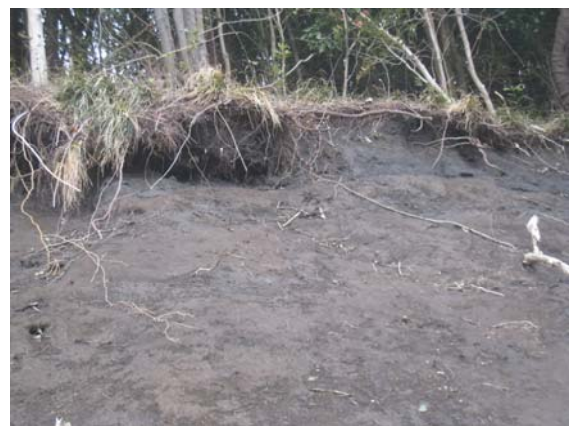
図-7 斜面中腹地山際の滑り境界。 厚さ1m以下,上部は黒色系,下は赤色系。
