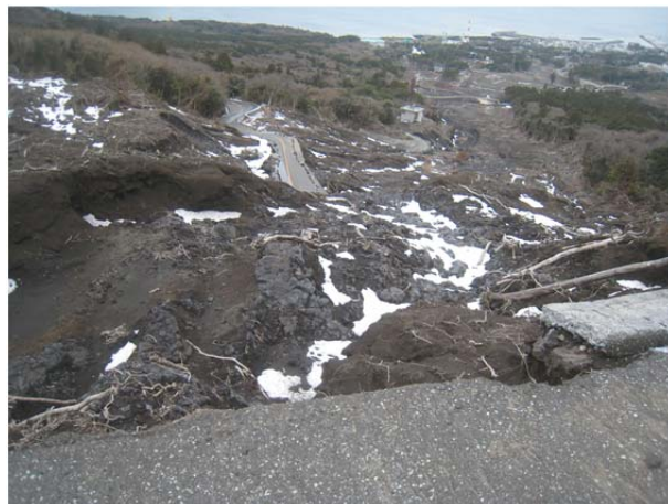
図-5 尾根筋 A-B を超えた泥流落下地点の浸食状況
