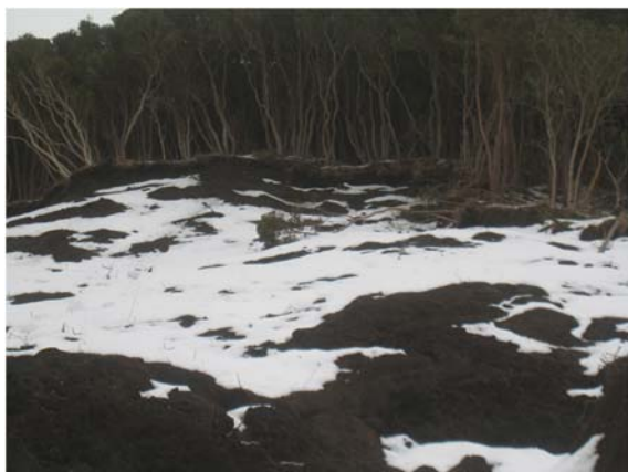
図-6 斜面上部地山際の滑り境界。 厚さ数10cm程度
