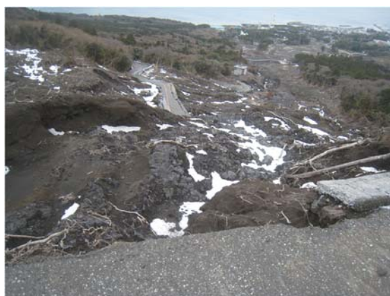
図-5 尾根筋 A-B を越えた泥流落下地点の浸食状況
