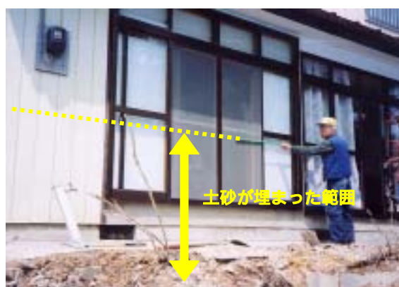
写真-2 被災当時の状況
