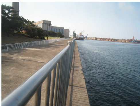
東側の正面護岸は前面への大きな移動は見られない。
