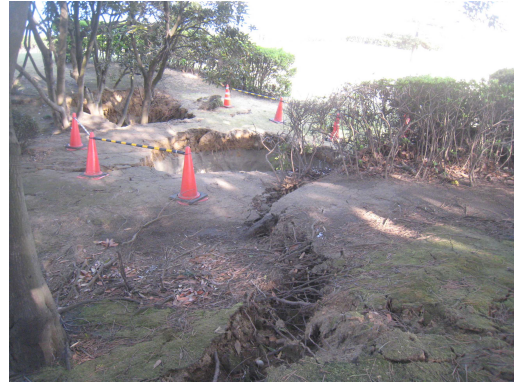
樹木の根を巻きこんだ陥没孔
