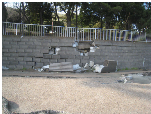
南側の船溜まり護岸の一部で前面への張出しが見られた。
