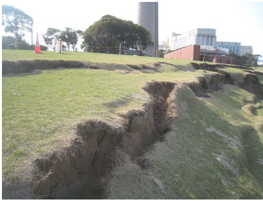
護岸に向かって 3 条ほどの開口・段差亀裂、右写真植込み横に陥没孔
