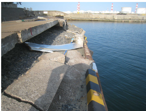
南側の船溜まり護岸の一部で前面への張出しが見られた。
