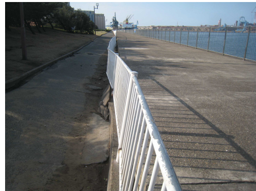
東側の正面護岸は前面への大きな移動は見られない。
