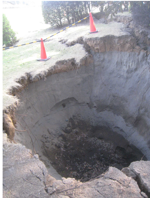
亀裂と深さ 3m ほどの陥没孔、30~50cm の表土の下は灰色の細砂が厚く堆積。
