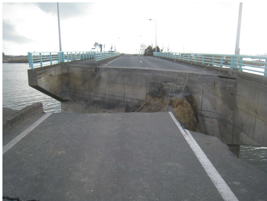
石巻港での橋台裏込土の津波洗掘による流失
