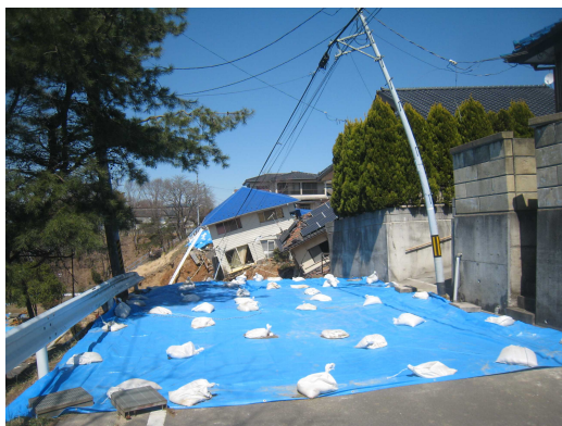
崩壊手前の道路から見る崩壊エリア
