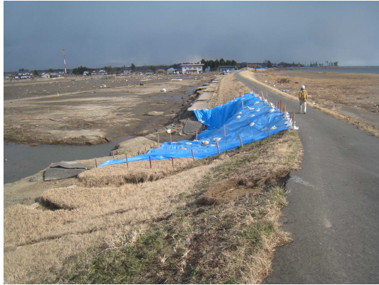
鳴瀬川河口近くでの津波による洗掘。堤防の芝が奇妙に削られている。
