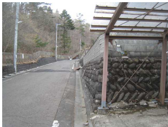
全く滑りのない地山に沿った盛土部の亀裂
