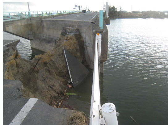
鳴瀬川河口近くでの津波による洗掘。堤防の芝が奇妙に削られている。
