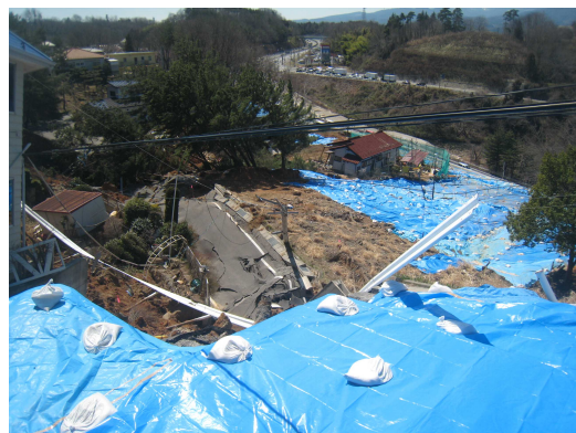
滑落した道路舗装と遠方の国道4号線
