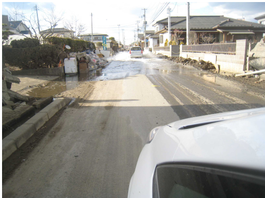
東松島市の住宅地は津波の被害は軽かったが、地盤沈下により高潮の影響を受けていた。
