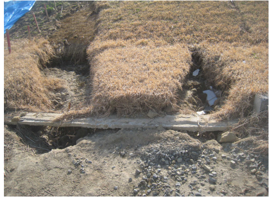
鳴瀬川河口近くでの津波による洗掘。堤防の芝が奇妙に削られている。
