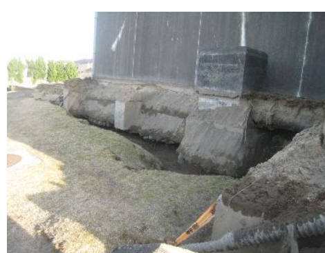
写真-12 河内町水道事務所敷地北側
