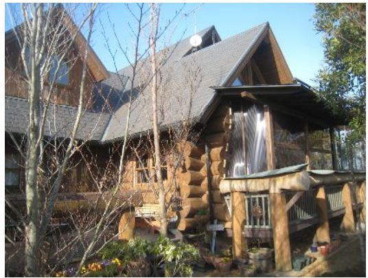
写真-4 一戸建てはスラブ基礎の上に立つログハウス
