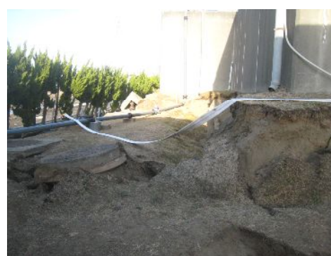
写真-10 河内町水道事務所北側
