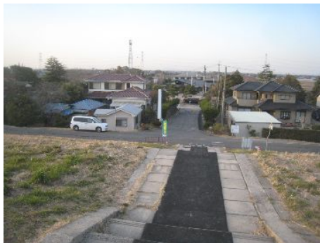
写真-17 カントリークラブハウス付近の堤防
