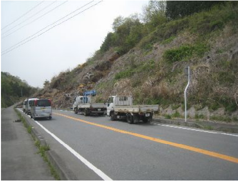
いわき市渡辺町上釜戸 崩壊斜面東部の剛体的な押し出し変形と舗装版の変形
