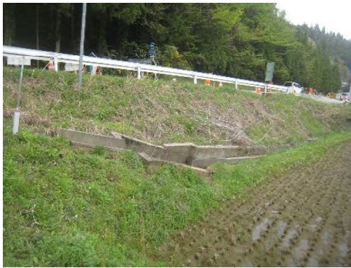
一倉で U 字溝に段差と変形を起こした断層
