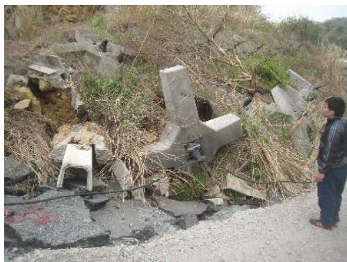
アンカー工の破壊モード
