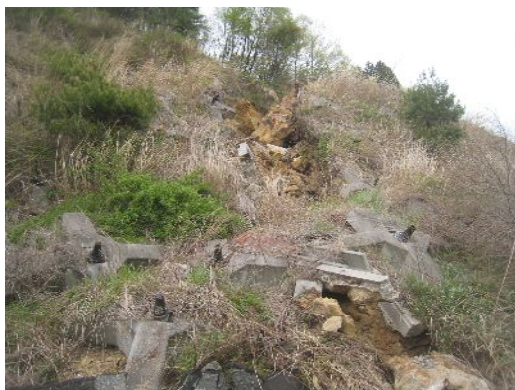
いわき市渡辺町上釜戸 崩壊斜面東部での岩盤剛体変形とアンカー工の破壊
