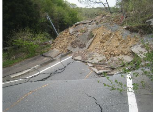
いわき市渡辺町上釜戸 崩壊斜面東部の剛体的な押し出し変形と舗装版の変形
