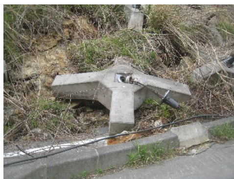
アンカー工の破壊モード
