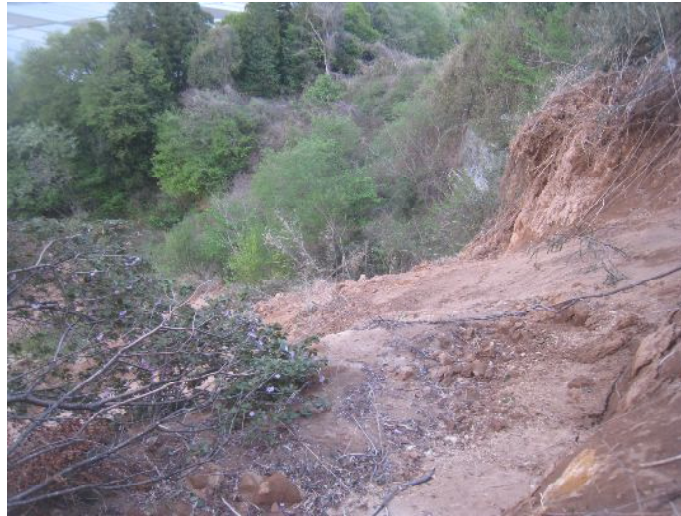
崩壊領域の右岸側
