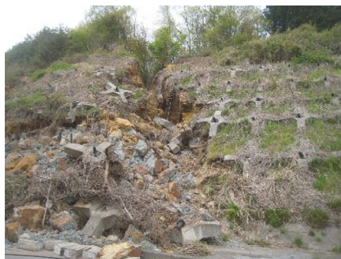
いわき市渡辺町上釜戸 崩壊斜面東部での岩盤剛体変形とアンカー工の破壊
