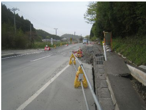
一倉で県道 134 号線に段差を起こした断層。左が北方向、右が南方向。
