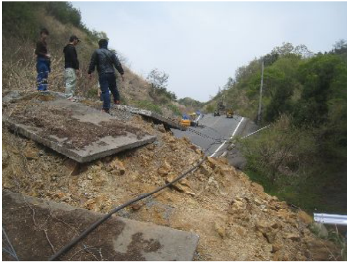
流動的崩壊への変化点と流動土砂の流下した谷筋
