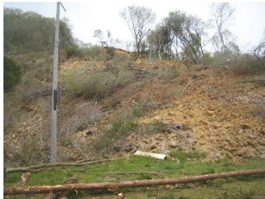
崩壊斜面西部の流動的崩壊
