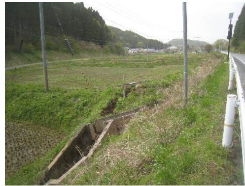
一倉で U 字溝に段差と変形を起こした断層
