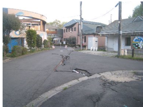
こぶしが丘温泉施設内の崩壊・亀裂と建物などへの影響
