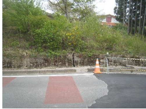
上ノ山の田人中学校北で 134 号線を通じた断層線。左は北方向、右は南方向
