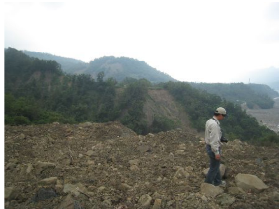
図-14 崩壊土で覆われた段丘から隣の影響を免れた段丘を望む。
