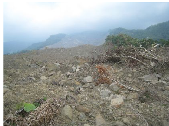
図-13 河岸段丘の上ののぼって上流の滑落崖を望む。累々と崩壊土が凹凸を繰り返しながら続いている。
