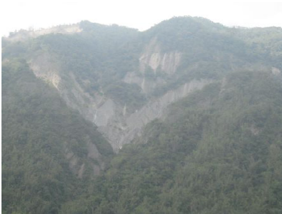
図-17 周辺の山の斜面崩壊も稜線に近いところから出発している。
