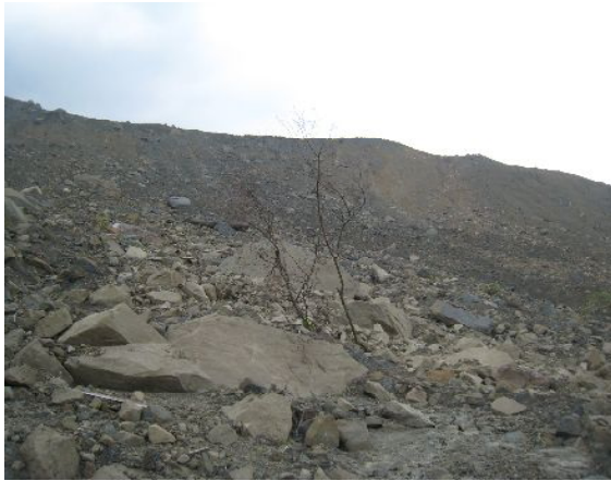
図-11 河岸段丘を崩落した崩壊土塊
