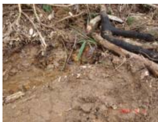
図-7 崩壊法面の南側境界付近での湧水
