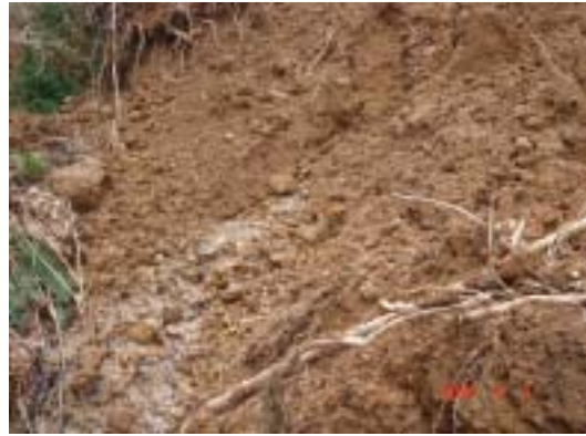
図-15 地点 2)の崩壊土塊の中からは湧水が観察された
