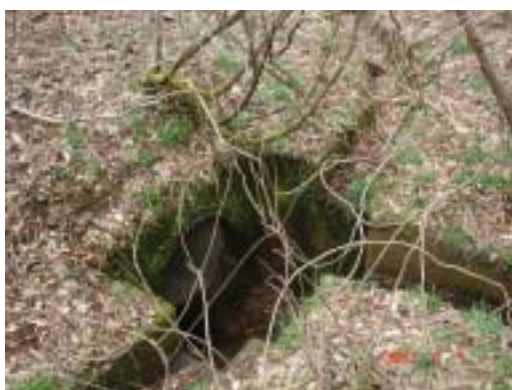
図-6 崩壊部より北側の盛土中に設置した コルゲートパイプによる沢水の排水
