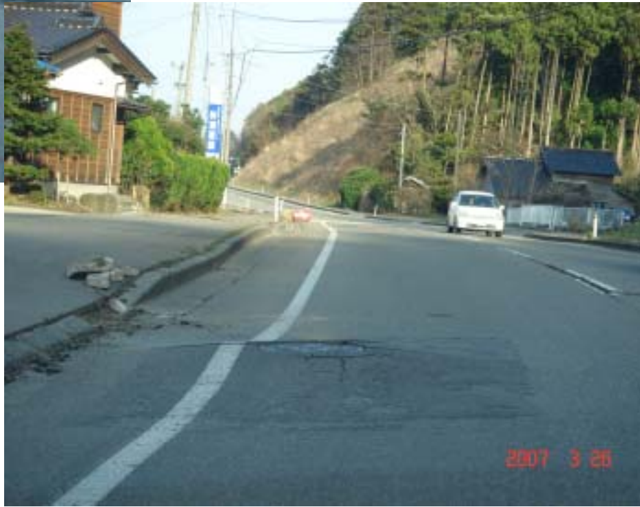
輪島市国道249下水マンホール付近段差
