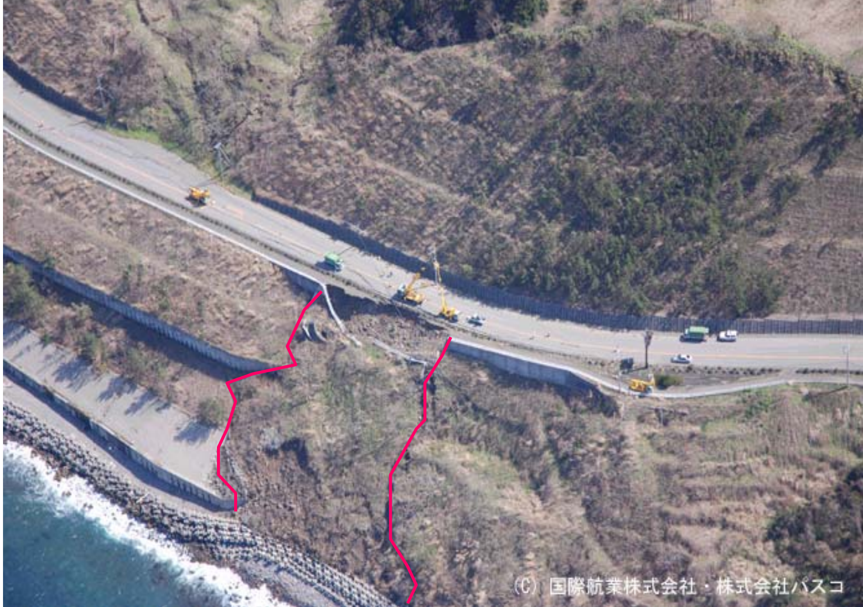
輪島市大野町寅崎付近(国際航業HPより)
