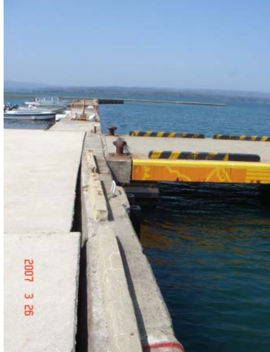
石川県七尾市和倉温泉(埋立護岸移動・背後地盤液状化・ 噴砂・沈下・流動)
