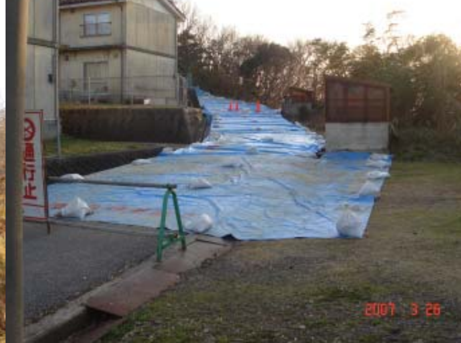
斜面法肩の市営住宅
