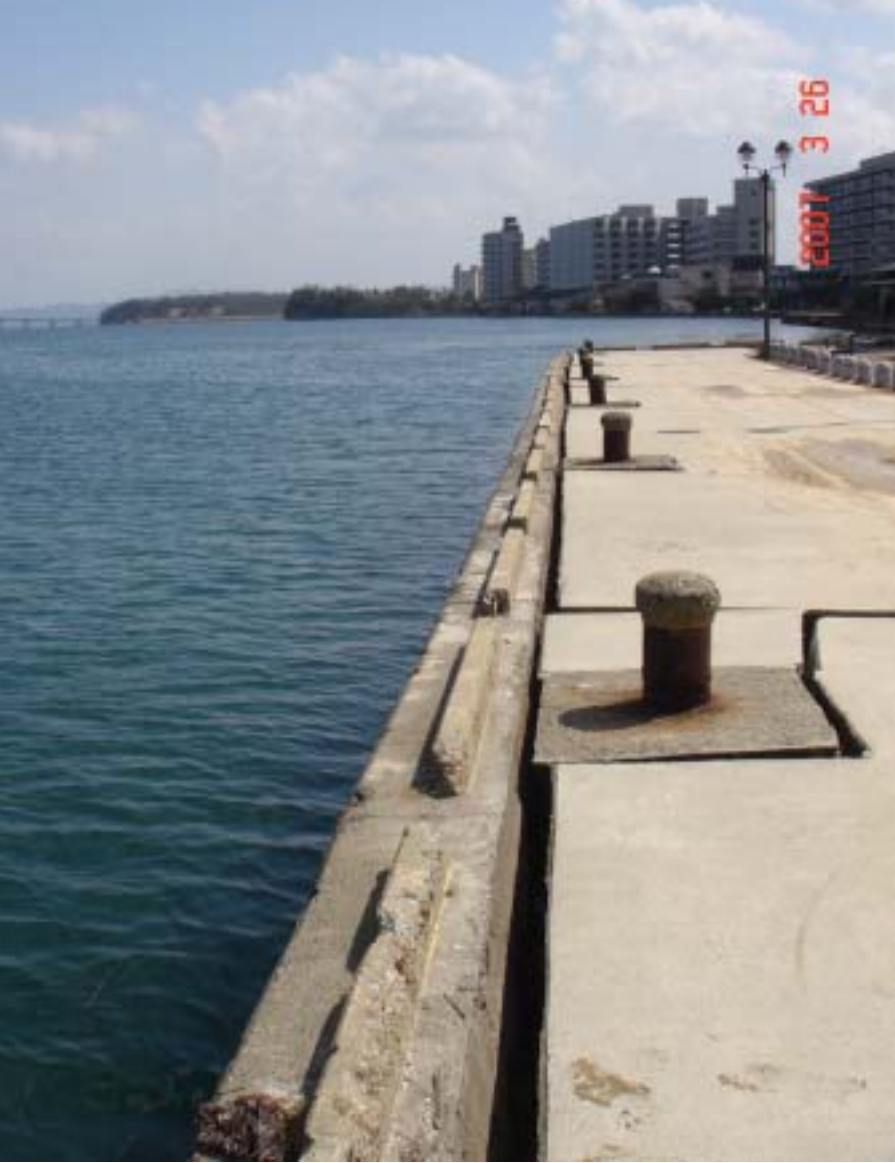
石川県七尾市和倉温泉(埋立護岸移動・背後地盤液状化・ 噴砂・沈下・流動)
