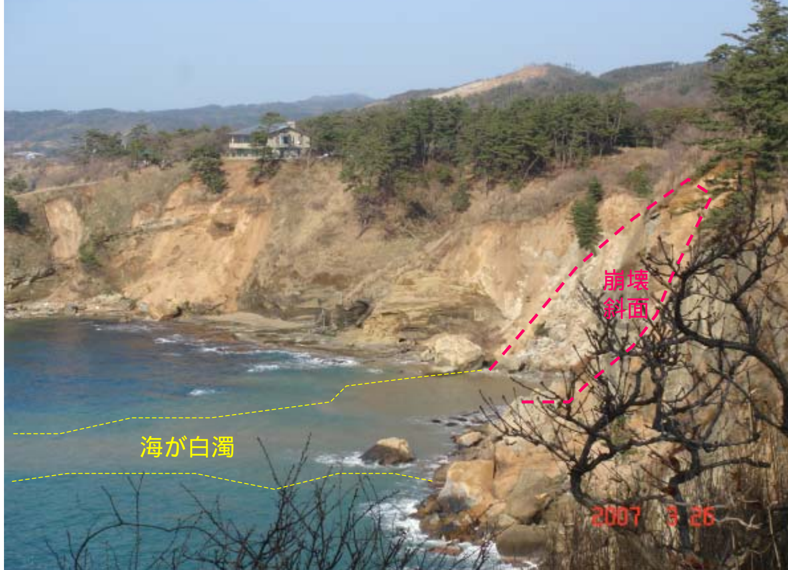
輪島市黒崎海岸斜面の崩壊
