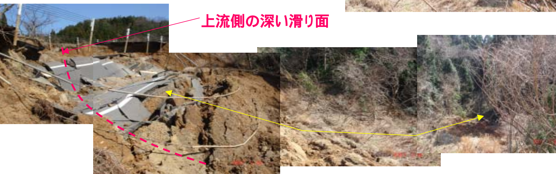
能登道路中島町谷内付近盛土崩壊 (流動距離が長い)
