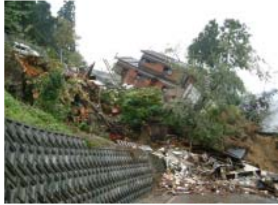
写真-8 長岡市濁沢町での崖錐上に造成した宅地の崩壊と家の倒壊
