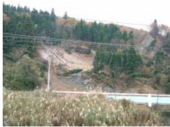
写真-10 小千谷市浦柄 JR 上越線沿いのケスタ地形流れ盤における泥岩鏡肌の滑り
