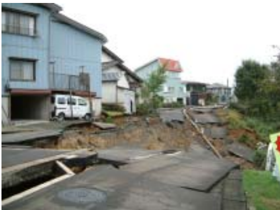
写真-5 長岡市高町での造成地周縁部の崩壊 亀裂は 20m ほど奥にまで及ぶ
