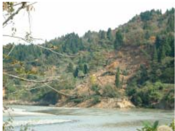
写真-12 信濃川魚沼橋下流右岸県道 196 号線での深い崩壊流れ盤と信濃川の蛇行侵食が影響
