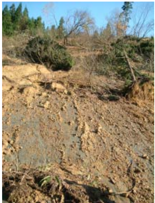
写真-23 滑り面上部を覆う2次滑り土塊
