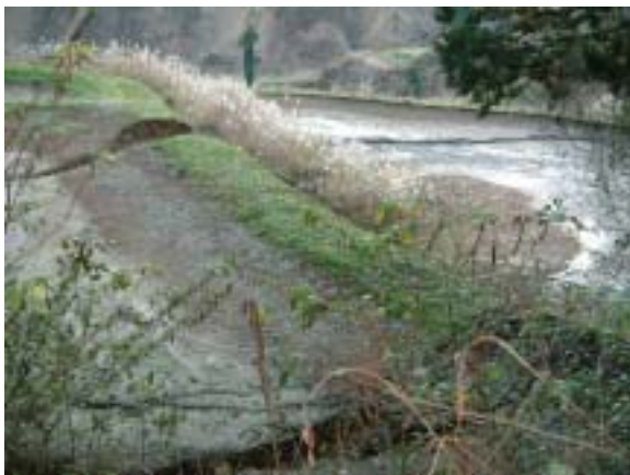
写真-15 パイピングによる池の破堤
