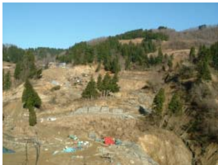
写真-25 手前の沢に向かって滑った寺野天然ダムの全景 後方のみでなく左右の滑落崖も確認できる
