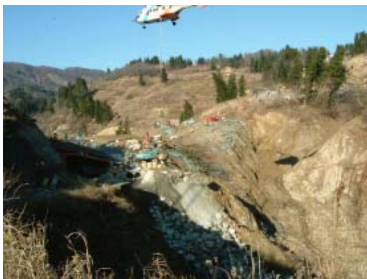
写真-26 寺野での沢を埋めた崩壊土と洗掘防止工の施工
