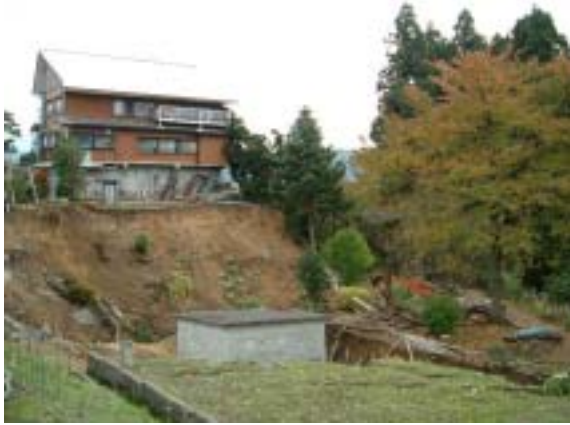
写真-7 小千谷市塩殿国道 117 号線横の河岸段丘上宅地の崩壊（奥や手前の土地と立ち木や小屋のある土地とは地続きであった）
