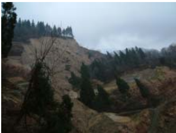
写真-17 小千谷市塩谷での大崩壊。滑り面から滑った上流土塊は斜め(25°)に傾斜して静止
