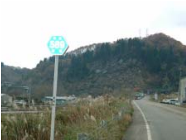
写真-11 小千谷市妙見町白岩での深い崩壊流れ盤と信濃川の蛇行侵食が影響
