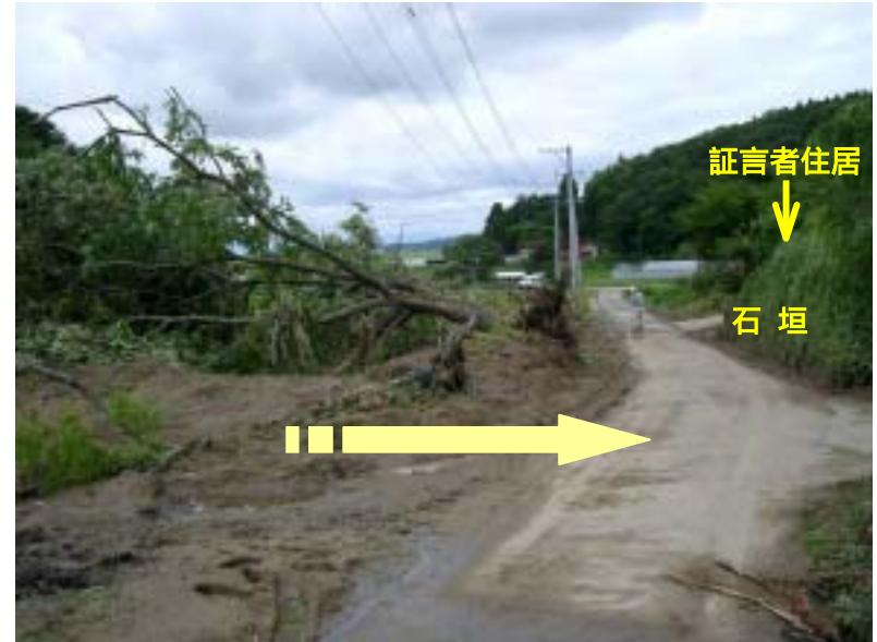
写真 - 2 地滑り先端部の状況（証言者住居の前は公道）
