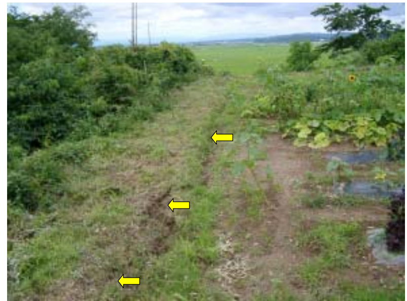
写真 - 4 丘の縁端部でのクラック発生状況（地滑り面の対面側）
