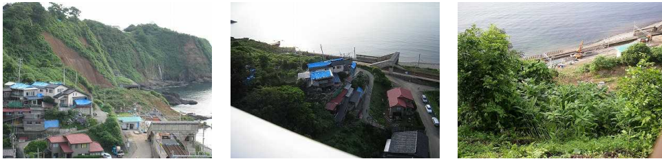
写真 3 JR 青海川駅背後斜面での斜面崩壊
