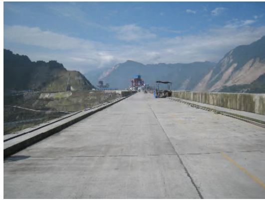
天端が中央で74cm沈下
