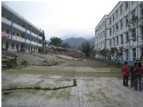
左側の新校舎と右側の旧校舎との間に逆断層が通過
