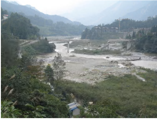
高原大橋遠景
