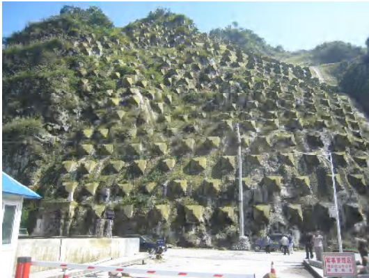
左岸地山切り取り斜面のロックアンカー
