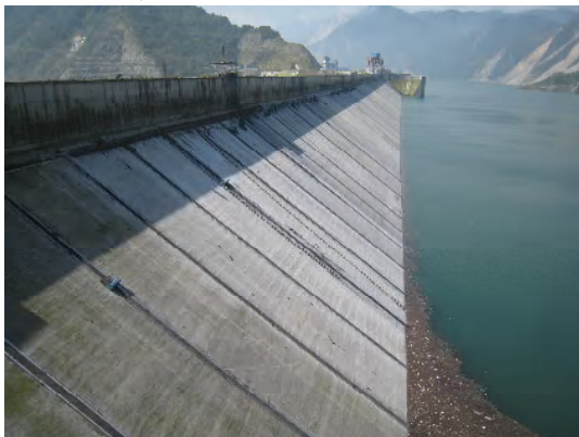
上流コンクリート遮水版
