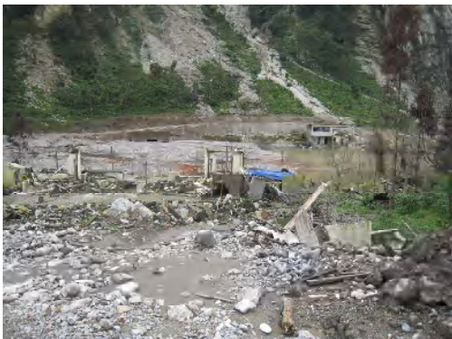
天然ダムで浸水しその後、砂礫で埋まった集落と家屋
