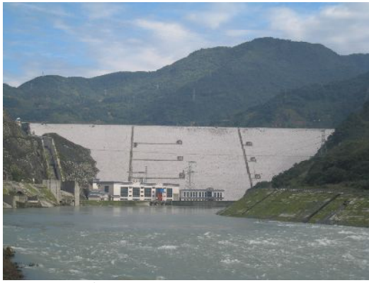
下流法面遠景
