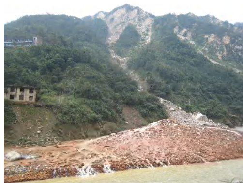
河床を埋める砂礫堆積層は少なくとも 2 層からなり、古い方は酸化が進んでいる。
