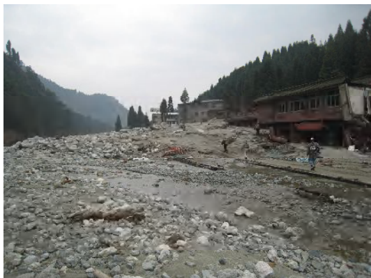
川沿いの建物の裏手から押し寄せた土石流
