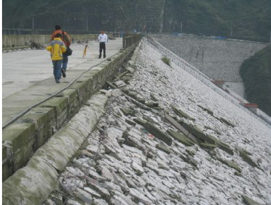
天端の沈下
