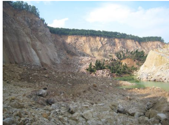
図-13 最上流滑落崖。上部溶結凝灰岩と下部堆積岩との間からの地下水が流出している（F地点より北東方向を見る）。
