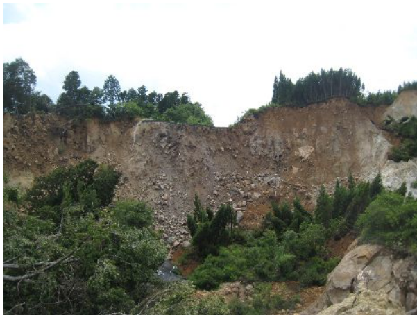
図-8 C 地点の道路が陥没した箇所で北側を見る。
