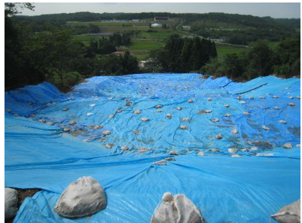
図-3 最上部から見た崩壊斜面
