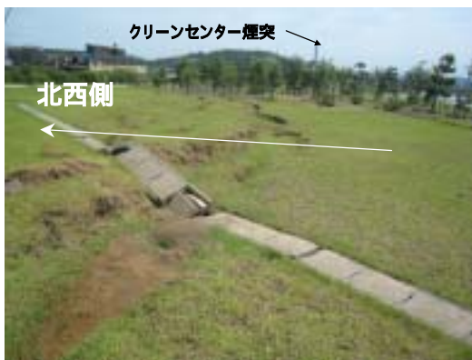
写真-5：鯖石川記念公園の亀裂(全体的には北西方向が30cmほど持ち上がっている)
