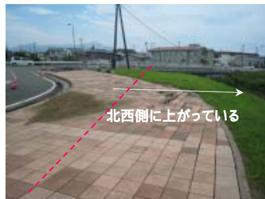
写真-6：鯖石川記念公園の駐車場(北西方向が30cmほど持ち上がっている)
